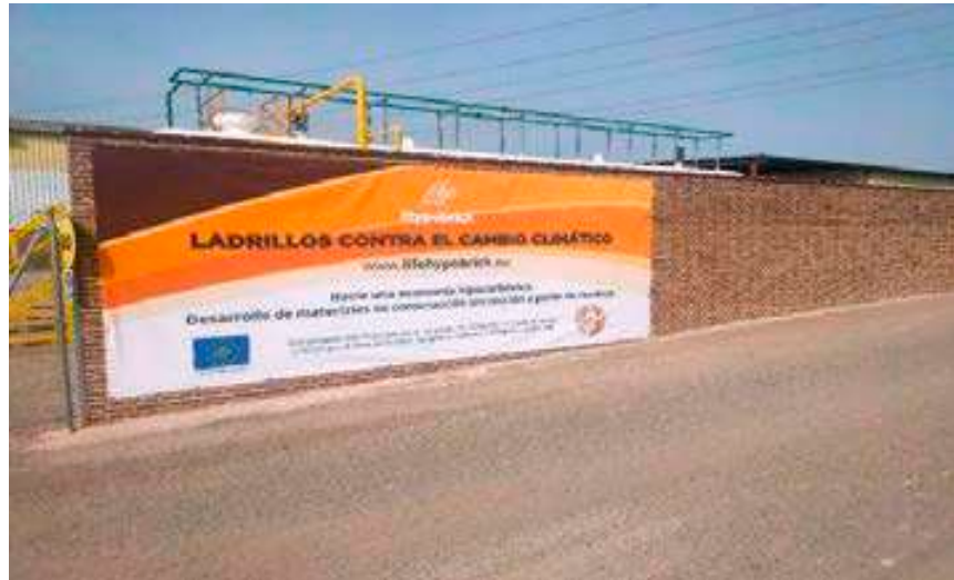
Figura 8. Muro fabricado con ladrillos sostenibles e instalado en Ladrillos Mora, Illescas (Toledo).
